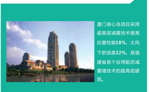
厦门湖心岛项目采用超高层减震技术提高抗震性能18%，大风下舒适度22%，是福建省首个应用阻尼减震墙技术的超高层建筑。
